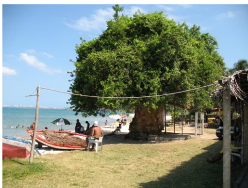
Fig. 8. Vista geral de parte do suposto forno da Armação de Porto Santo. Foto: Fabiana Comerlato. Data: 27/10/2008.
