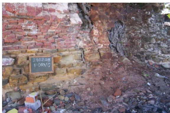
Fig. 9. Parte com tijolos maciços argamassados, criando uma forma abaulada. Foto: Carlos Costa. Data: 02/2008.
