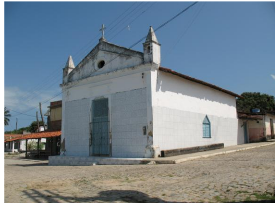
Fig. 17. Vista geral da capela de Manguinhos. Foto: Fabiana Comerlato. Data: 27/10/2008.
